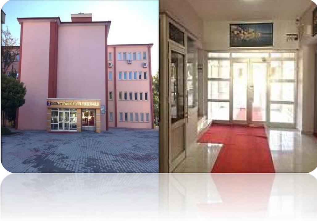
Şekil 1: Yüksekokulumuzun bina girişi ve genelgörüntüsü.
