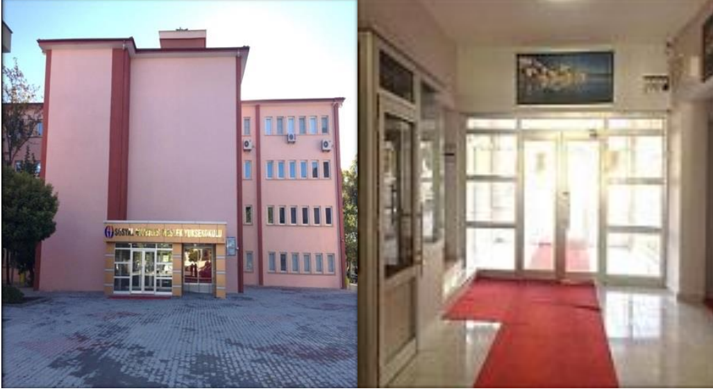
Şekil 1: Yüksekokulumuzun bina girişi ve genelgörüntüsü.
